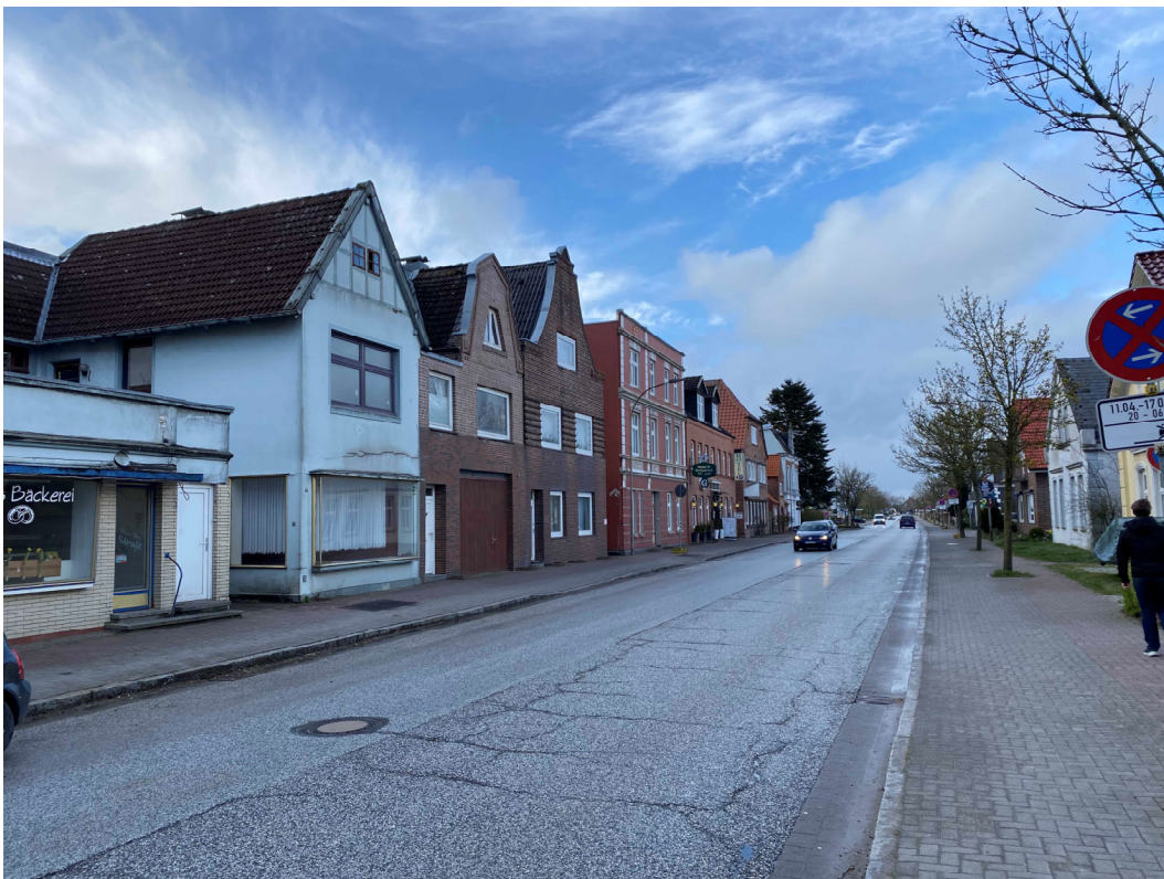
Abbildung 4: Königstraße, Höhe Haus Nr. 35, Blickrichtung Süd -> Nord
